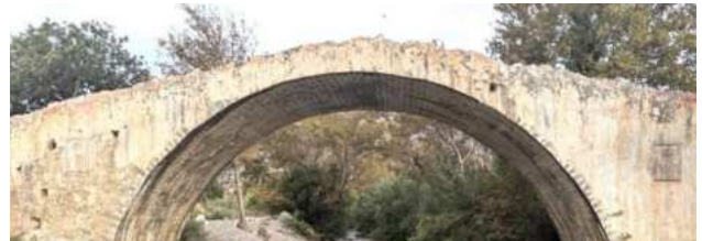
Brücke über den Kourtaliotiko Fluss (19. Jahrhundert)
